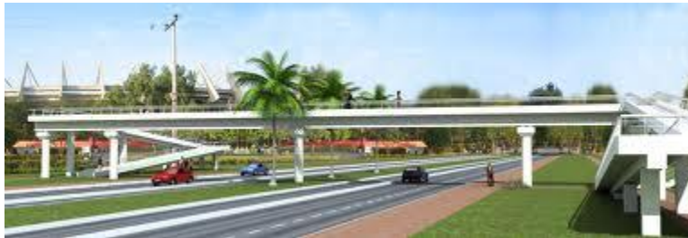
Figura 9. Puente de Concreto Pre-esforzado
