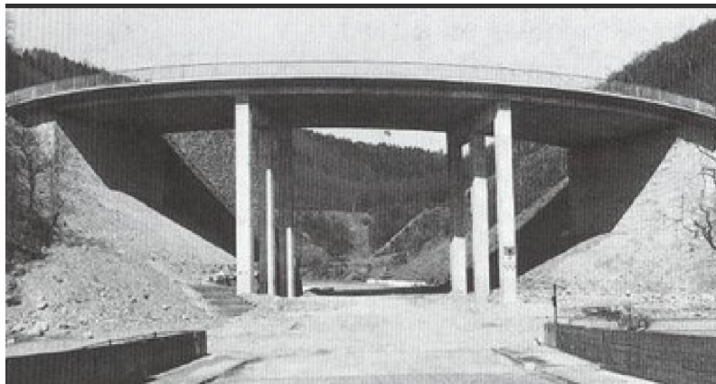
Figura 8. Puente de Concreto Armado
