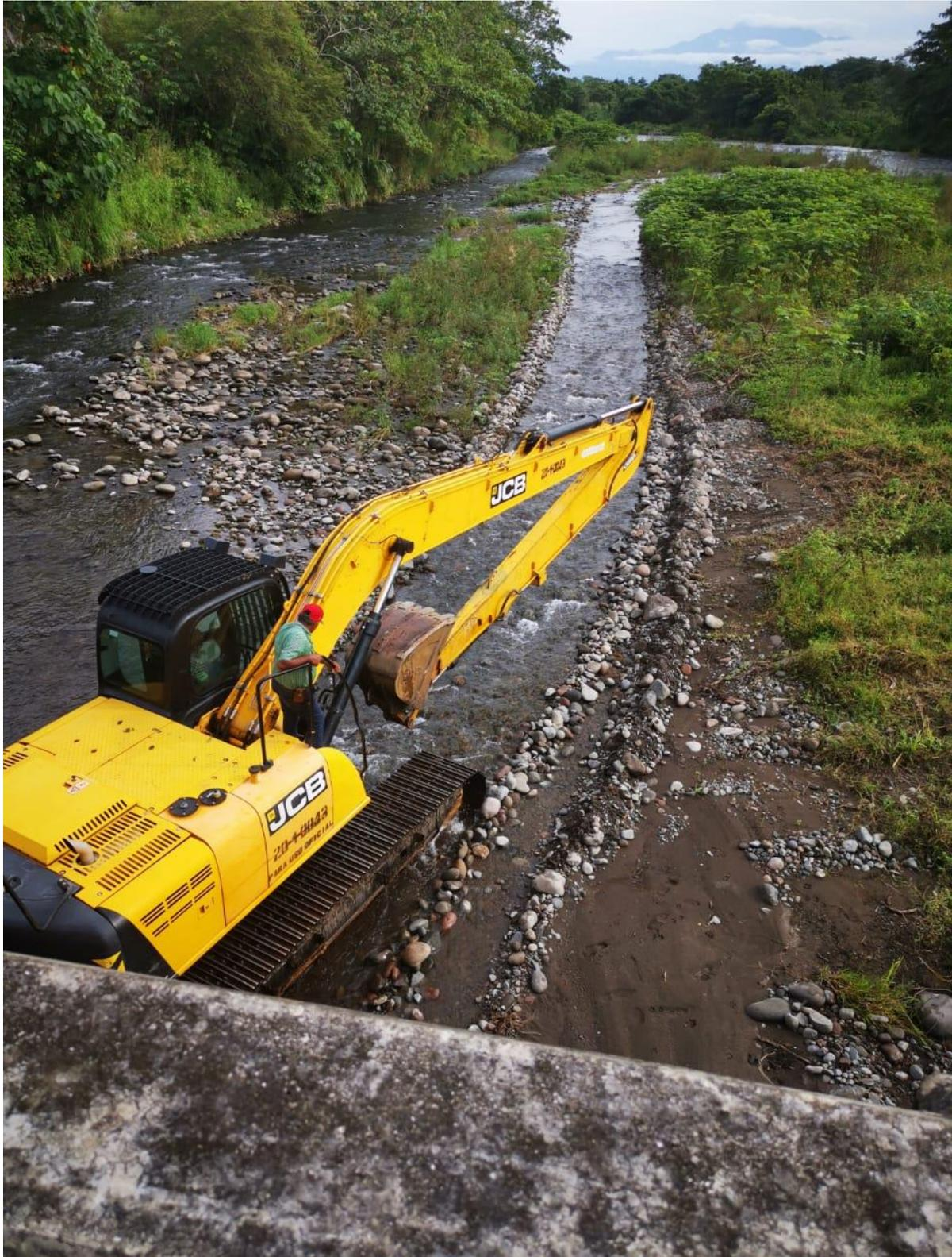
Obra en cauce para protección de Talud de Puente, Rio Escarrea, Panamá.
