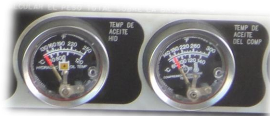
Figura 30. Indicadores de temperatura en cabina
